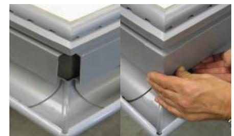
**9** Zum Abschluss werden die Außenecken, ebenfalls mit BLANKE DIBA-COLL aufgeklebt. Für die gesamte Montage des Rinnensystems ist kein spezielles Werkzeug erforderlich.
