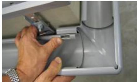
**5** Dichte Stoßverbindungen werden mit den Rinnenverbindern und Eckformteilen hergestellt. Verbindungen mittig über den Stoß, bis zur Markierung, zusammenfügen. Durch die Doppeldichtgummielage, in den Verbindern, ist die Abdichtung der Stöße gewährleistet.
