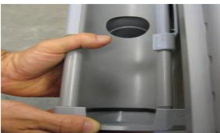
**7** Die Endkappen mit Dichtsteckverbindungen werden an den Enden der Rinne aufgesteckt.
