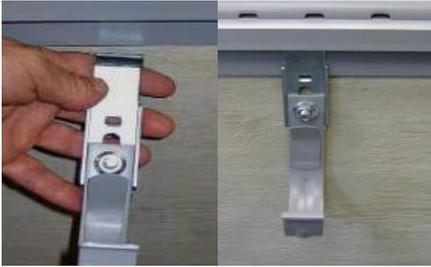
**1** Die Rinneneisen einfach in die Vorrichtung des jeweils passenden Balkonrandprofils einhängen und zum Profil hin einklicken (wie auf Skizze S.1 gezeigt). Den maximalen Abstand von 65 cm nicht überschreiten. (Die Vorgehensweise ist bei der eckigen und runden Variante identisch. Beispielshalber wird die runden Variante gezeigt.)
