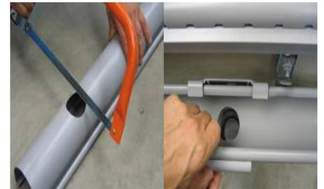
**6** Zum Anschluss eines Abflussrohres wird über dem Ablaufstutzen ein Rinnenteil mit Loch (vor Ort, mit einer Säge, max Ø 40 mm) erstellt und durch den Ablaufstutzen befestigt.
