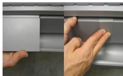
**8** Die Traufabdeckblende einhängen und einklicken (wie auf Skizze S.1 gezeigt). Anschließend wird über die Stöße ein Verbinder, mit BLANKE DIBA-COLL, aufgeklebt.
